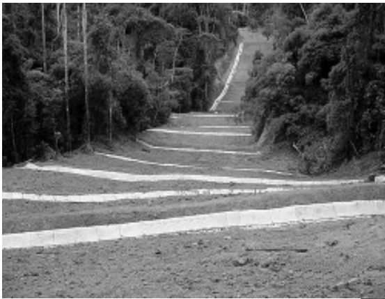
Fig. 39. Estabilización de pendientes.
