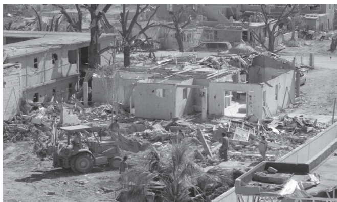
Figura 30 Daños en el Fraccionamiento Villa de Fuentes, Piedras Negras, Coahuila, 24 de abril de 2007
